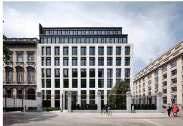
REGENT PARK – KANTOORGEBOUW
